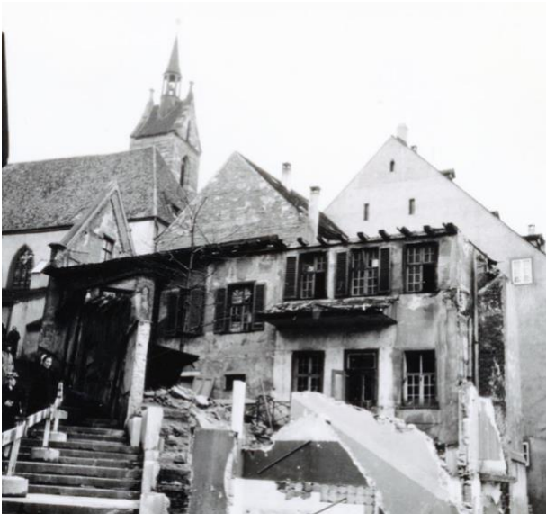
Die Baustelle für das Storchen-Parkhaus, hinten der Turm der Peterskirche
