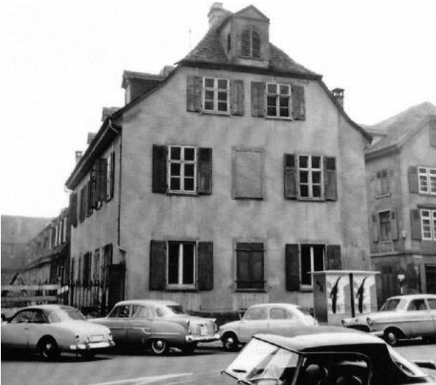
Der Kopfbau des Rosshofs, um 1960, kurz vor dem Abriss
